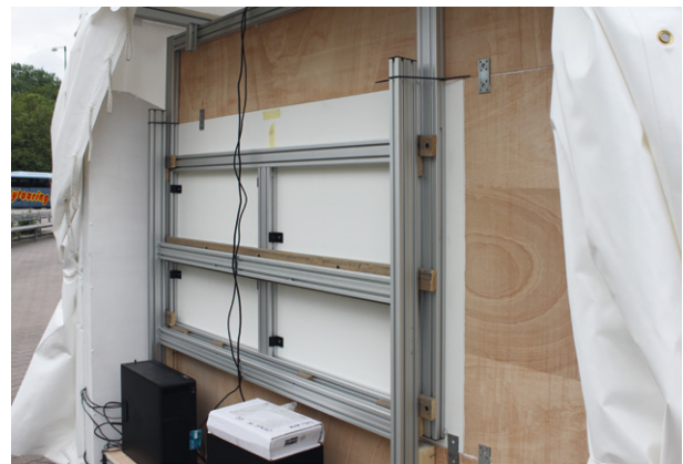
Bild 23: Konstruktion der mobilen Multimediale Wand
